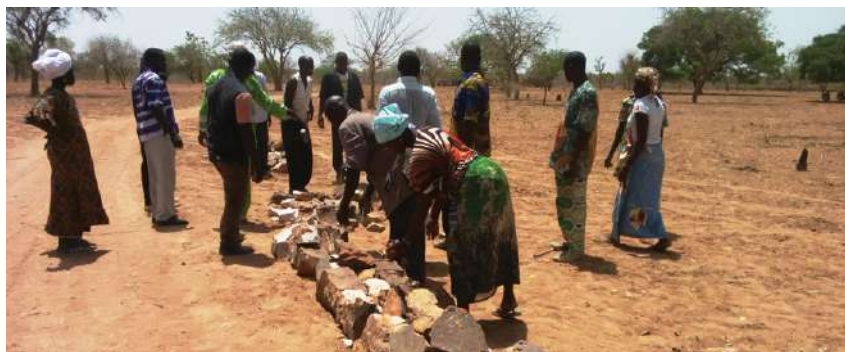
Formation pratique_ Construction de cordons pierreux
