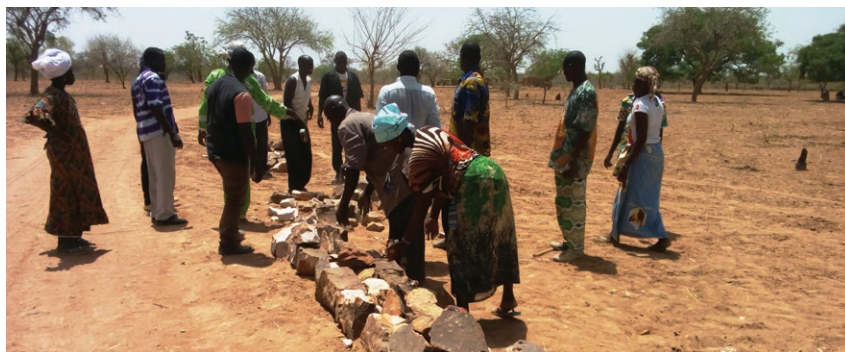
Formation pratique_ Construction de cordons pierreux
